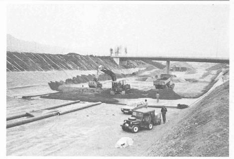
Fig. 5. — Au-dessus de la couche de sable, on a remblayé avec des matériaux d'excavation du tunnel jusqu'à la cote inférieure du corps formant chaussée. Grâce au bas positionnement de l'étanchéité on a pu éviter que celle-ci soit percée par des installations de toutes sortes (exception fondation du pont) de la chaussée.
