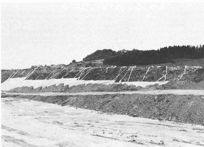
Fig. 9. — Vue sur le chantier du Breitfeld. On reconnaît une partie des feuilles d'étanchéité en Sarnafil FP qui sont remontées le long des talus et fixées grâce aux rubans enroulés pour faciliter la pose. En partie, les remblais sont déjà exécutés dans la zone horizontale ainsi que le long des talus. (Photo prise par l'auteur)
