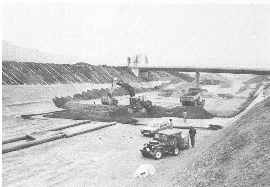
Fig. 5. — Au-dessus de la couche de sable, on a remblayé avec des matériaux d'excavation du tunnel jusqu'à la cote inférieure du corps formant chaussée. Grâce au bas positionnement de l'étanchéité on a pu éviter que celle-ci soit percée par des installations de toutes sortes (exception fondation du pont) de la chaussée.
