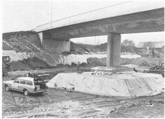
Fig. 3. — Seule la fondation d'un pont traversant la NI perfore l'étanchéité. La feuille d'étanchéité synthétique d'une épaisseur de 2 mm a été raccordée hermétiquement à la fondation par un procédé développé par le fournisseur.
