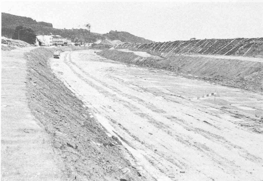
Fig. 6. — Vue sur la future N1 dans le Breitfeld, à l'ouest de Saint-Gall. A droite, on reconnaît les rubans grâce auxquels les feuilles d'étanchéité synthétiques ont été tirées sur les talus. Ces rubans ont également servi à la fixation des feuilles d'étanchéité. Ensuite, après la pose de la couche protectrice de sable de 20 cm d'épaisseur, on a commencé la mise en place des remblais, clairement visibles à gauche et à droite sous forme de bermes, au milieu du tracé il manque encore une partie du remblayage.
