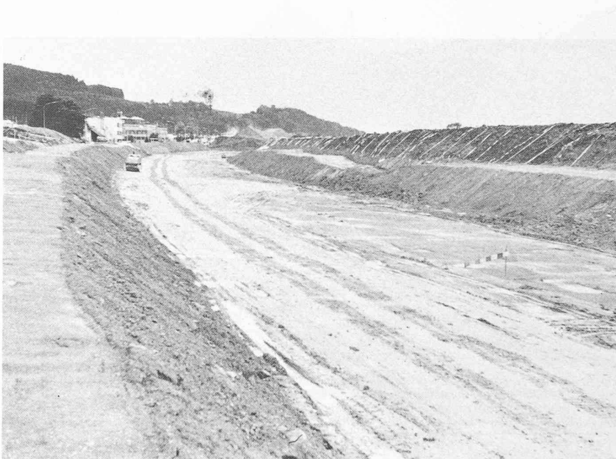
Fig. 6. — Vue sur la future N1 dans le Breitfeld, à l'ouest de Saint-Gall. A droite, on reconnaît les rubans grâce auxquels les feuilles d'étanchéité synthétiques ont été tirées sur les talus. Ces rubans ont également servi à la fixation des feuilles d'étanchéité. Ensuite, après la pose de la couche protectrice de sable de 20 cm d'épaisseur, on a commencé la mise en place des remblais, clairement visibles à gauche et à droite sous forme de bermes, au milieu du tracé il manque encore une partie du remblayage.
