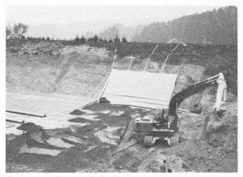
Fig. 4. — Après la pose des feuilles d'étanchéité synthétiques, tout en les remontant le long des talus, y compris la fixation suivante, une couche de sable de 20 cm d'épaisseur est mise en place avec des machines comme couche protectrice mécanique pour les feuilles de l'étanchéité. Les tas de sable épars érigés avant la pose de la couche de sable servent à charger les feuilles d'étanchéité synthétiques.
