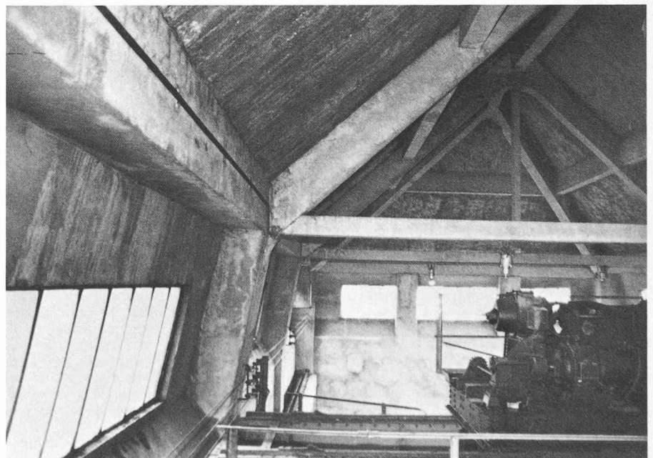
Ancienne usine hydro-électrique de Chèvres (Vernier/GE). Intéressante structure de la toiture, en béton ; à droite treuil sur pont roulant (capacité de levage : 40 t) construit par les Ateliers Jonneret. Ce bâtiment, édifié dans les années 1916-1920, sera démolé sous peu. L'API envisage la possibilité de sauvegarder tout ou partie du treuil. De plus, aucun dossier de construction n'étant conservé, l'API s'efforcera de combler cette lacune avant et pendant la démolition (photos, croquis, enregistrement vidéo) afin que ne disparaisse pas totalement un témoignage de l'architecture industrielle de ce siècle. Document API/Photo Atelier Pattusch.
