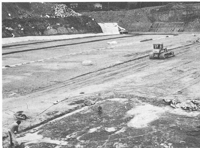
Fig. 7. — La décharge aménagée et contrôlée de Châtel-Saint-Denis dans sa phase d'imperméabilisation du fond. Une feuille de plastique est déposée, soudée et pincée entre des couches argileuses, de manière à éviter les perforations.
