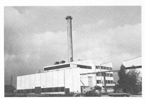
Fig. 4. — Après modification des filtres existants et l'adjonction de filtres supplémentaires pour le traitement des fumées, l'usine d'incinération d'Yverdon répond aux normes fédérales sur la protection de l'air.
