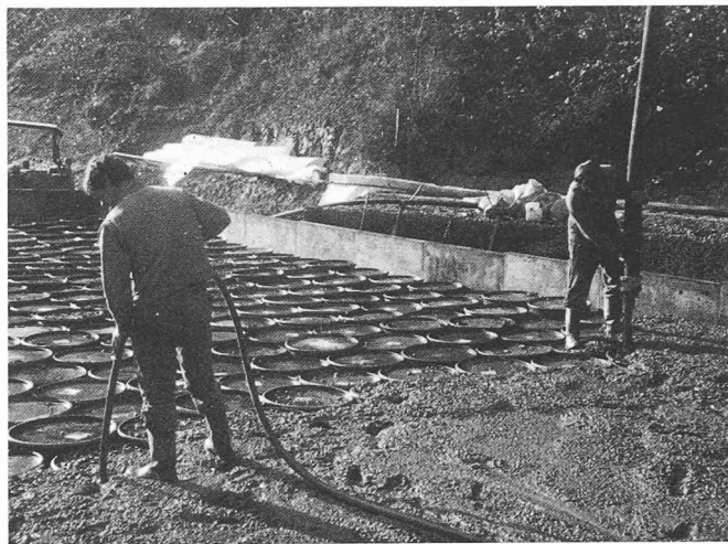
Fig. 8. — La partie supérieure de la décharge aménagée et contrôlée du Teuftal (classe III) est équipée en décharge chimique spéciale (classe IV) par et pour l'industrie bâloise.
