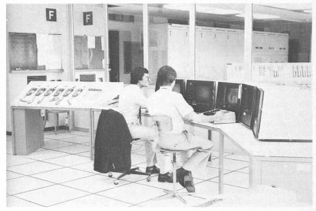
Fig. 2. — 3000 points distincts de surveillance et de commande sont reliés au centre de contrôle.
