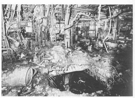
Fig. 1. — Explosion dans une fabrique de produits chimiques. Même la dalle de béton armé a cédé sous la violence de l'explosion.
