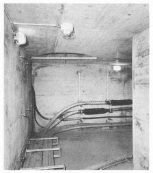
Fig. 12. — Un détecteur surveille l'infiltration de gaz naturel dans un local souterrain servant au passage de câbles.
