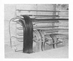
Fig. 13. — Détecteur de gaz propane dans une galerie technique.
