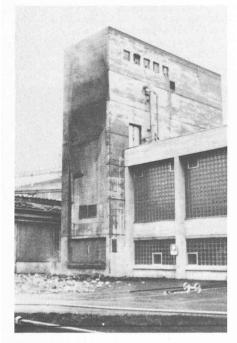
Fig. 3. — Point faible planifié dans un silo. Comme prévu, c'est la paroi construite en briques, alors que les trois autres sont en béton armé, qui a cédé sous la pression de l'explosion. On peut toutefois se demander si l'explosion n'aurait pas pu être selon toute probabilité évitée, si le bâtiment avait disposé d'un système de détection qui aurait détecté l'allumage d'une étincelle et déclenché l'extinction dans le système pneumatique. tème pneumatique.
