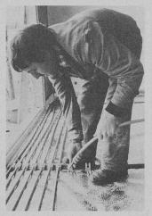
La feuille isolante intégrale est l'élément clef de l'économie d'énergie réalisée grâce au chauffage par le sol Caloflex. Elle réduit la déperdition de chaleur vers le bas et contribue, en outre, à une insonorisation des tuyaux d'eau chaude. Les calculs nécessaires au montage du système sont traités sur ordinateur selon un programme informatique différencié ; il en résulte, en tous points du local, une répartition correcte de la température de surface. (Photo: Marcus Fischer.)
