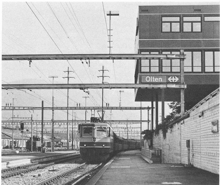
Les transformations de la gare d'Olten ont comporté la création d'un nouveau quai à l'est des perrons existants. Le poste d'enclenchement surplombe partiellement le nouveau quai.
