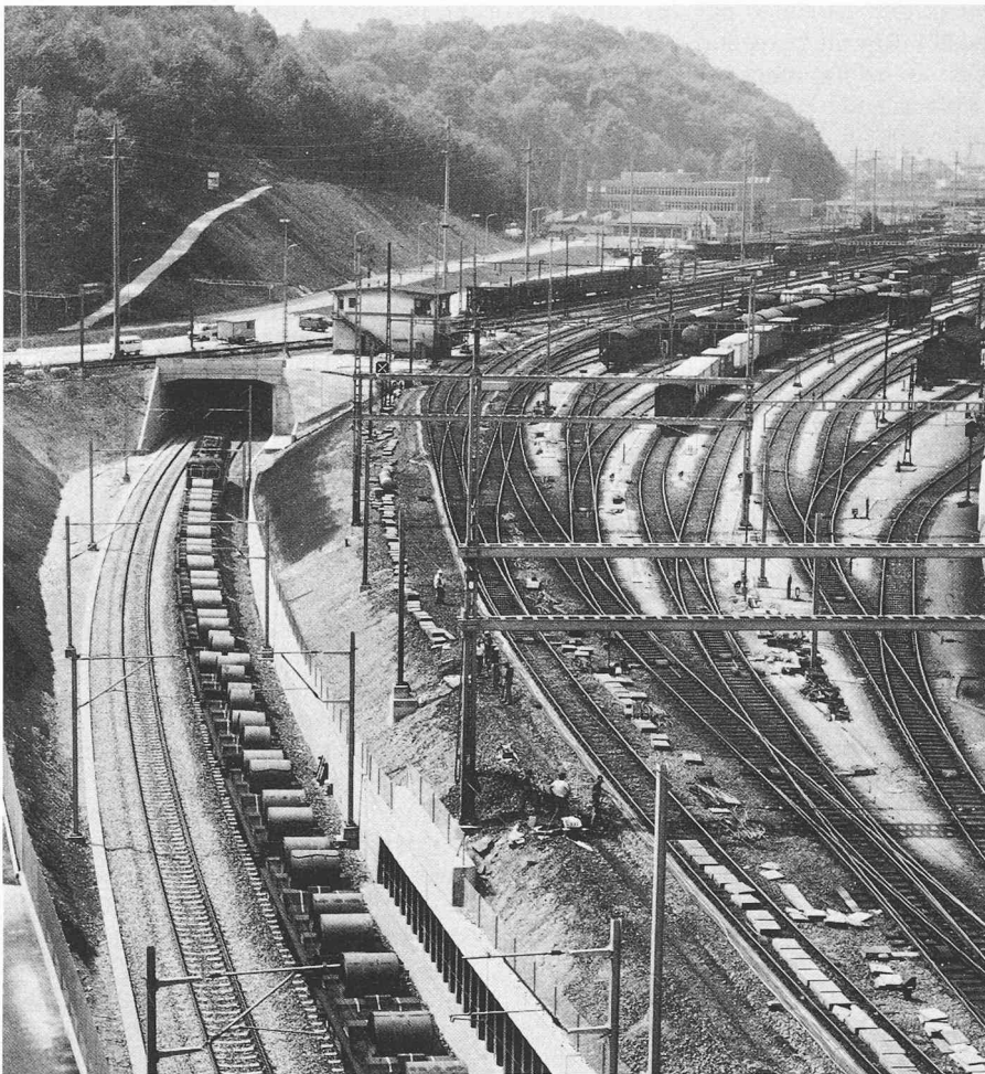
Les deux axes de circulation principaux sont déjà en partie séparés: au nord de la gare, la ligne de Bâle passe sous celle de Zurich (au premier plan à gauche). A l'arrière-plan, on aperçoit le nouveau bâtiment qui abrite le poste d'enclenchement d'Olten.
