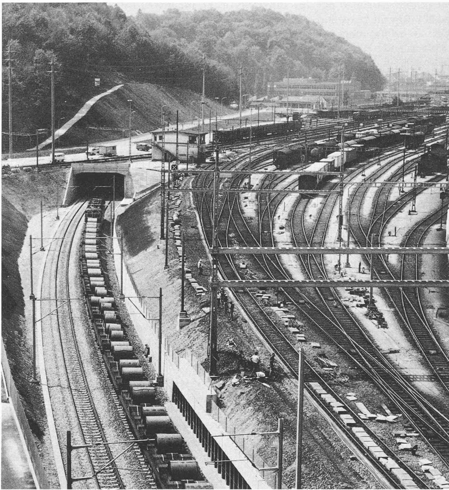
Les deux axes de circulation principaux sont déjà en partie séparés: au nord de la gare, la ligne de Bâle passe sous celle de Zurich (au premier plan à gauche). A l'arrière-plan, on aperçoit le nouveau bâtiment qui abrite le poste d'enclenchement d'Olten.
