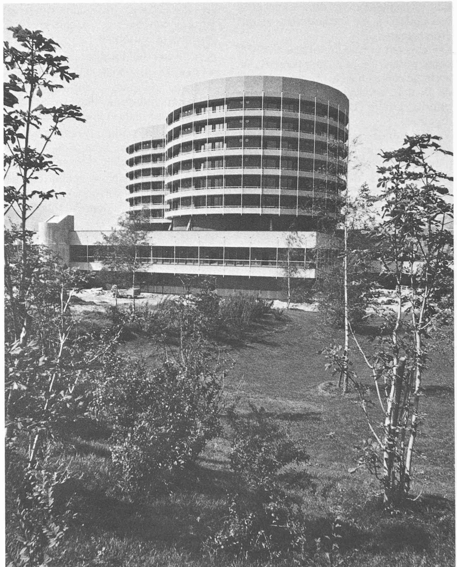
Vue générale de l'hôpital régional de Sion - Hérens - Conthey (Photo O. Ruppen).
