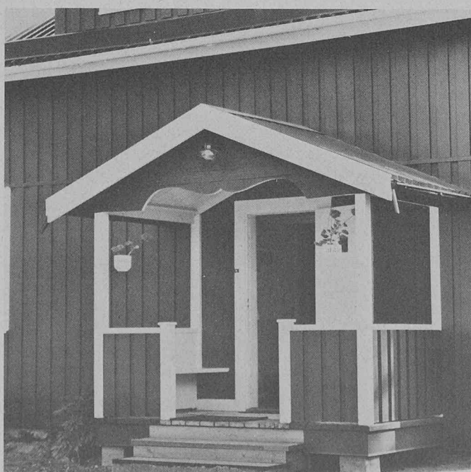
Fig. 1. — L'extérieur de cette maison vieille de 60 ans a été restauré grâce à un bardage en acier recouvert avec le film résistant aux intempéries de Du Pont «Tedlar» PVF, tout en préservant l'intégrité architecturale de cette construction typiquement suédoise en pans de bois.
