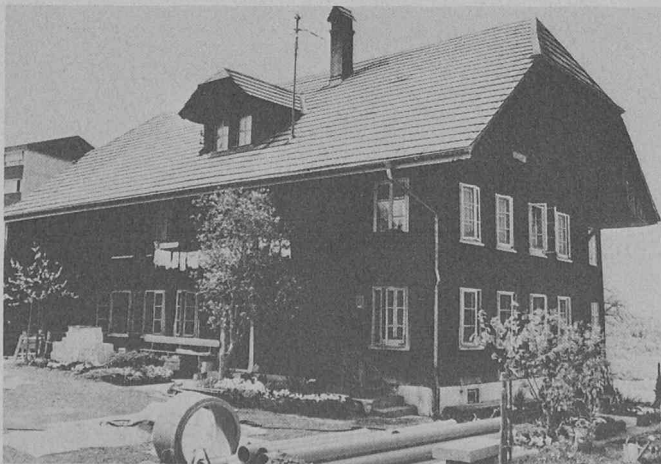
Fig. 1. — La ferme rénovée, près de Schwarzenbourg, pendant les travaux de transformation.
