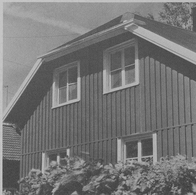
Fig. 2. — Profil, grain et couleur du bardage revêtu de film «Tedlar» PVF s'assortissent bien avec les pans traditionnels suédois, mais le matériel Du Pont ne nécessite aucun entretien.
