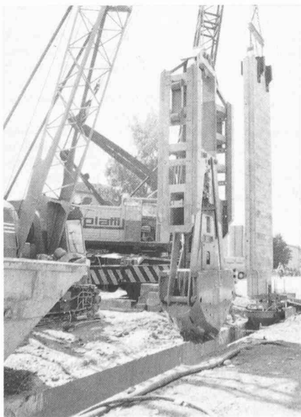
Fig. 2. — Creusage d'une tranchée et mise en place d'un élément de paroi préfabriqué.
