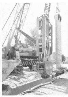
Fig. 2. — Creusage d'une tranchée et mise en place d'un élément de paroi préfabriqué.
