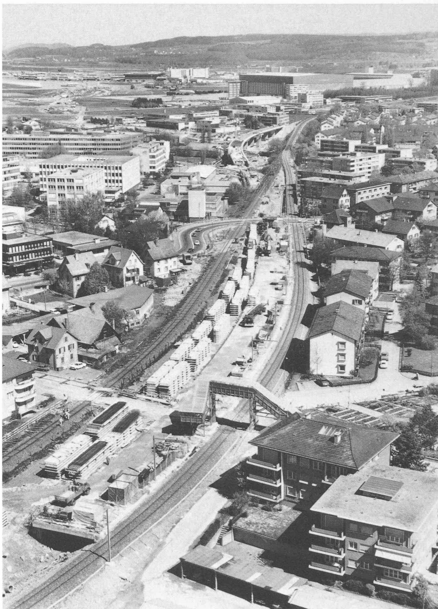
Fig. 1. — Opfikon. Vue générale des travaux en juin 1977, après le ripage provisoire de la ligne de Kloten (à gauche, l'ancien tracé).
