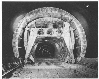
Fig. 6. — Lot est. Portique de cintrage pour le bétonnage de la voûte intérieure, après l'application de l'isolation élastique.
