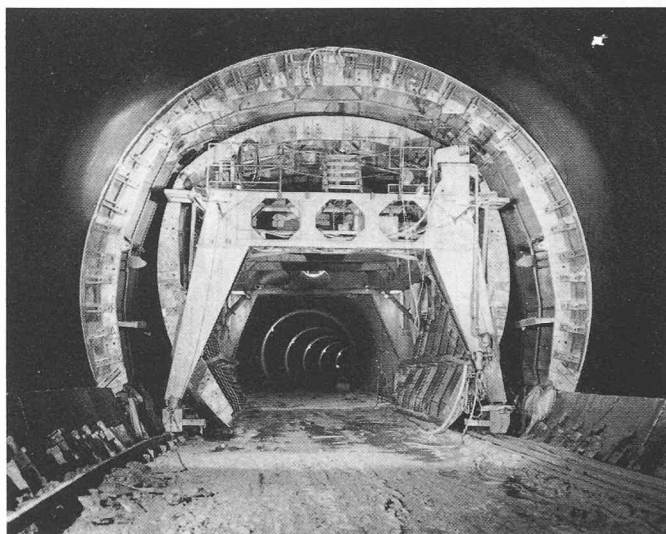
Fig. 6. — Lot est. Portique de cintrage pour le bétonnage de la voûte intérieure, après l'application de l'isolation élastique.
