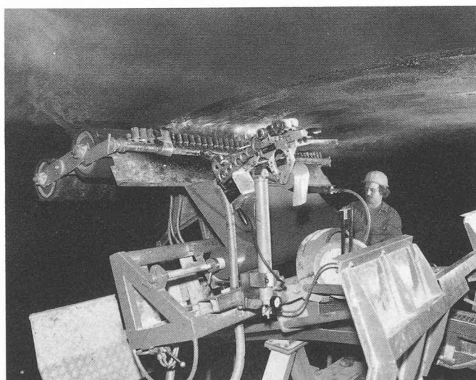
Fig. 5. — Lot ouest. Application des feuilles isolantes sur la voûte extérieure
