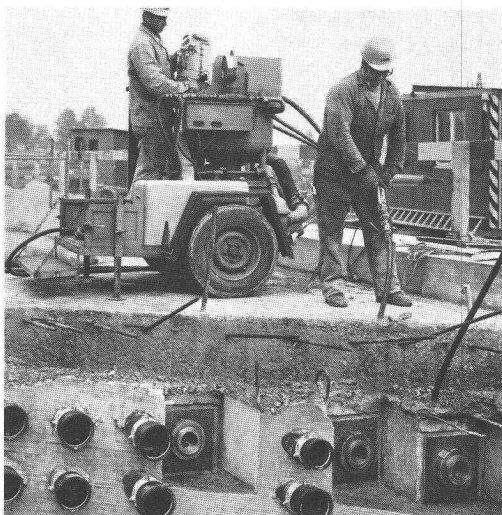
Des monteurs bien formés et expérimentés injectent les câbles BBRV avec soin et dans les délais.
