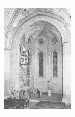
Fig. 11. — Mise en place des fils d'invar dans le plan horizontal supérieur du chœur.
