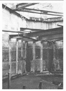
Fig. 5. — Paroi berlinoise et étayage dans l'angle côté chœur, pieu 23.
