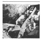
Chargeuse Häggloader 9HR pour une évacuation rationnelle des déblais de mi-
