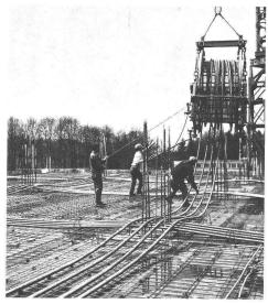
Précontrainte de dalle plate STAHLTON en bandes d'appui, Pose simultanée, en une phase, des quatre câbles d'une bande avec le dérouleur.
