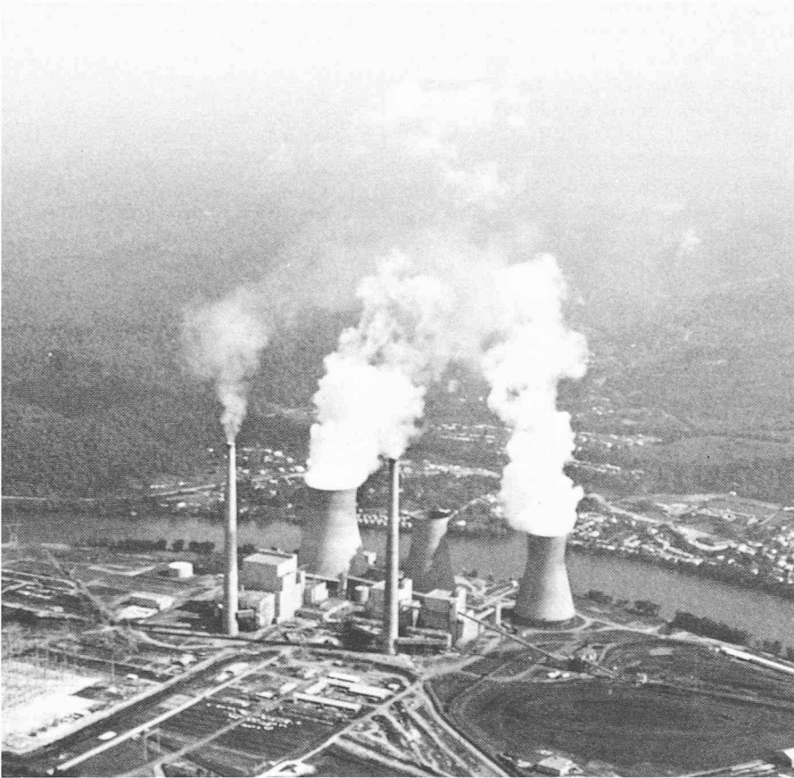
Centrale à houille Amos 3 (USA). La centrale de gauche (turbine de 1300 MW et 2 générateurs de 122 MVA) correspond à ce qui est envisagé pour Bâle. Cette photo préfigure une installation sur les bords du Rhin, où la région est toutefois beaucoup plus fortement peuplée.
