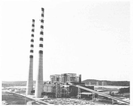
Centrales Cumberland 1 + 2, Tennessee Valley Authority (USA), chacune équipée d'une turbine de 1300 MW et de deux générateurs de 722 MVA. Refroidissement avec l'eau de la rivière. Les deux cheminées dépassent 300 m de hauteur. Les 24 000 t de houille consommées quotidiennement sont amenées par voie fluviale.
