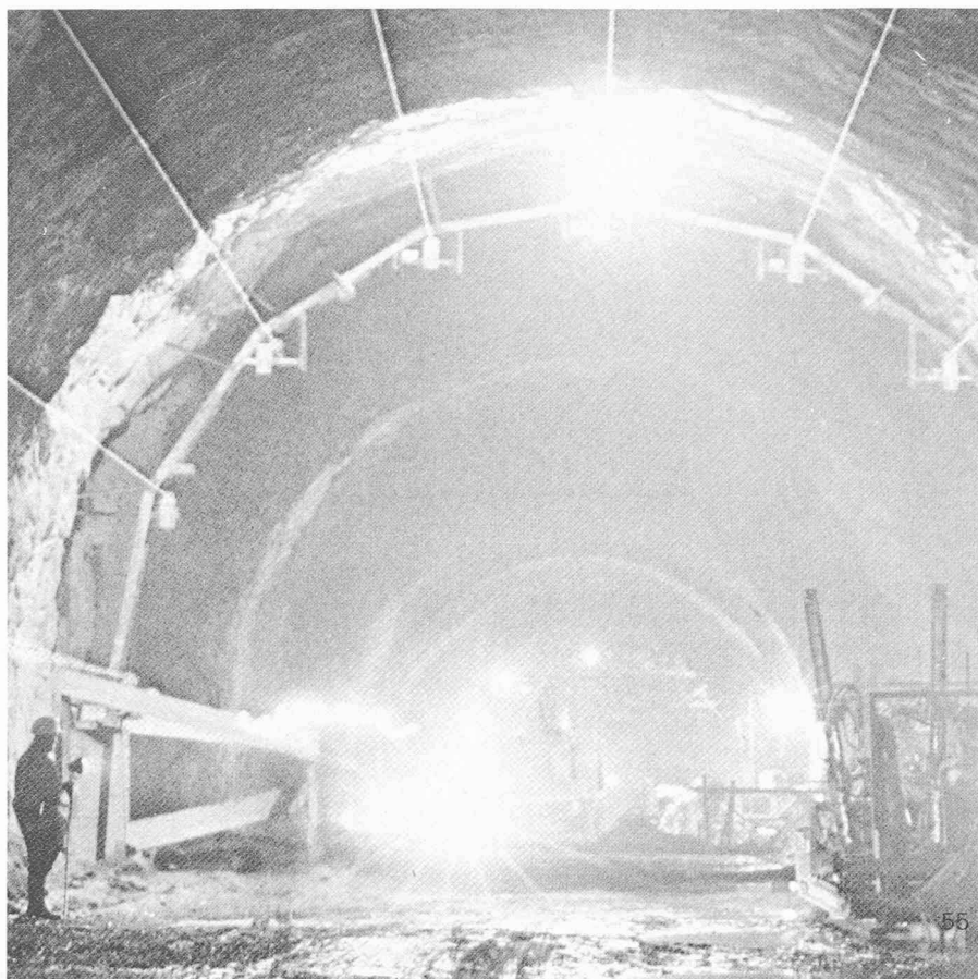
Fig. 7. — Au lot nord on utilisait pour le contrôle et le marquage du profil d'excavation neuf appareils-lasers montés sur un portique le long du pourtour du tunnel. Ils étaient déplacés régulièrement à chaque étape d'avancement de 300 m. Les rayons lasers servaient aussi au marquage du schéma de forage sur le front d'attaque du tunnel.
