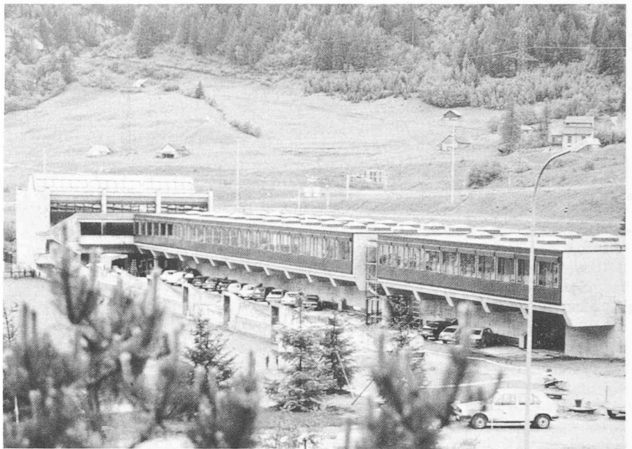
Fig. 11. — Emplacement du centre de manutention d'Airolo; les travaux sont presque achevés.
