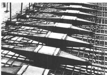
Poutre préfabriquée avec un ancrage mobile type A 2350
