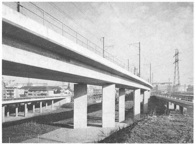
Fig. 4. — Les ponts qui enjambent le tracé de la future autoroute de la vallée de la Glatt. Vue prise en direction de la sous-station de Seebach.
