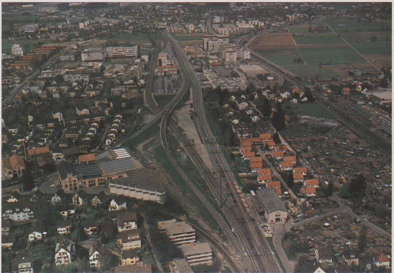
Fig. 1. — Les ponts d'Oberhauserried.
