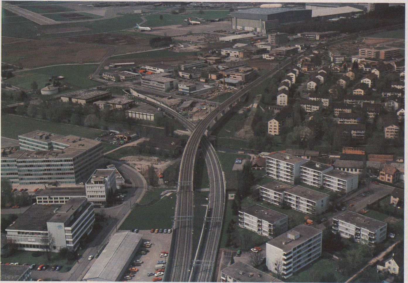
Fig. 5. — Vue générale des ponts sur la Glatt. A gauche: la ligne de l'aéroport se jette dans le tunnel de l'aéroport. Au-dessus: la ligne régionale de Kloten.
