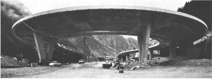
Dans cet ouvrage avec de multiples courbures horizontales et verticales des câbles, l'influence de frottement représente une part significative de l'ensemble des pertes lci, on voit particulièrement clairement l'avantage des faibles valeurs de coefficients de frottement des câbles BBRV.
