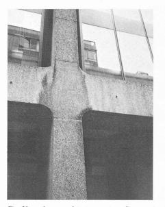
Fig. 20. — Les granulats apparents ne dispensent pas de l'écoulement des eaux.
