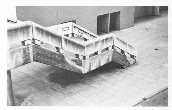
Fig. 17 et 18. — Escalier non étudié (écoulement des eaux).
