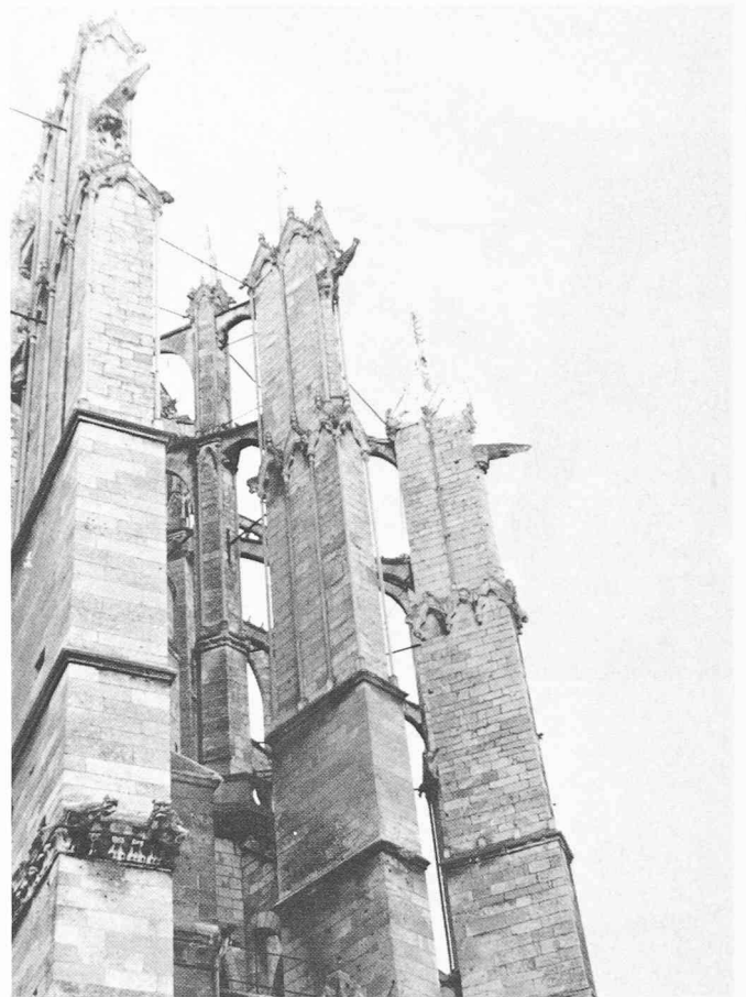
Fig. 6 et 7. — Sur ces ouvrages en pierre on notera l'importance de l'exposition d'une façade (Hôtel de Ville de Gand, à gauche), ou des larmiers et gargouilles qui écartent l'eau (Cathédrale de Beauvais, à droite).
