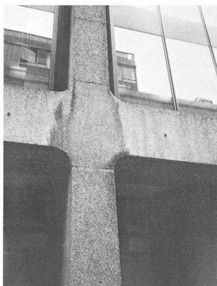
Fig. 20. — Les granulats apparents ne dispensent pas de l'écoulement des eaux.
