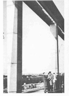
Fig. 1. — Reprise de bétonnage : un motif aussi simple qu'une ligne d'ombre suffit pour en atténuer l'aspect.
