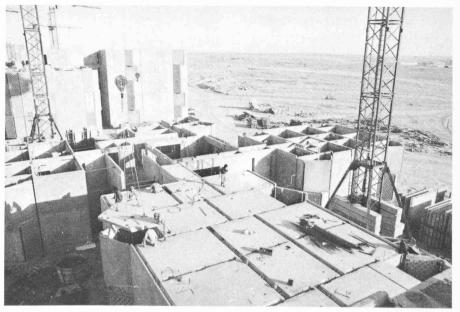
Fig. 4. — Montage des éléments préfabriqués.
