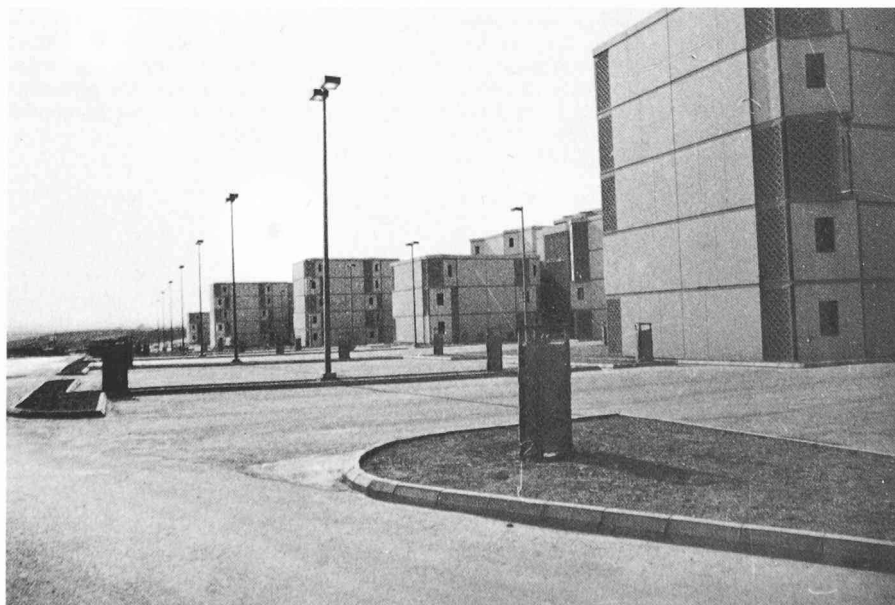
Fig. 6. — Vue d'un des parkings de la cité universitaire.
