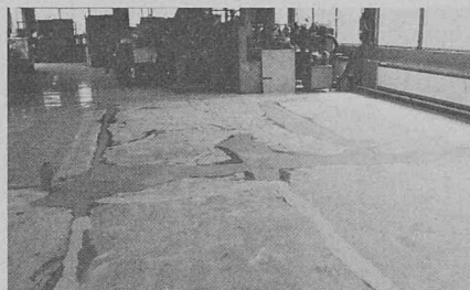
Réagrégé des sols précités au moyen de masses epoxy Famaflor.
