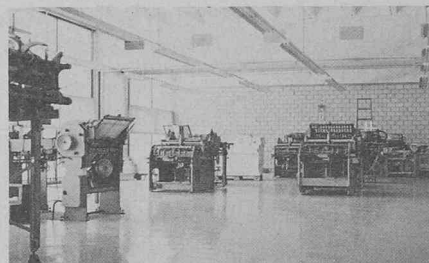
Revêtement Famaflor appliqué sur sol béton consolidé avec masses epoxy.
