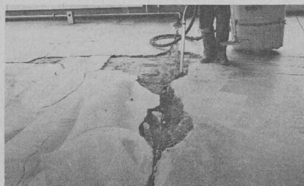
Chape ciment présentant de nombreuses fissures, trous, effritement, etc.
