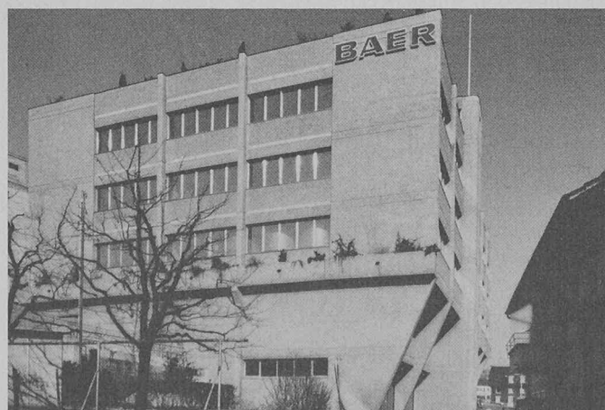
Pour sa nouvelle unité de production de Küssnacht/Rigi, le plus grand fabricant suisse de fromage à pâte molle, E. Baer & Cie, a opté pour un programme d'économie d'énergie mûrement étudié. Avec la réutilisation de la chaleur du système de chauffage, une isolation conséquente et des vitrages Thermoplus, il est parvenu, en janvier 1980, à économiser approximativement 18 000 litres d'huile de chauffage comparativement à l'année précédente.
