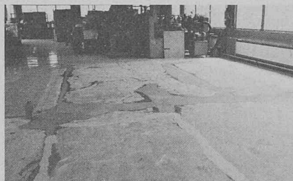
Réagréage des sols précités au moyen de masses epoxy Famaflor.
