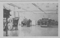
Revêtement Famaflor appliqué sur sol béton consolidé avec masses epoxy.
