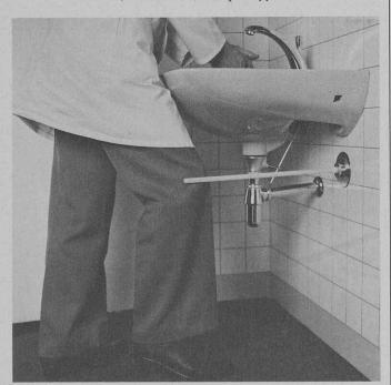
Kuglopress Nº 2732 avec commande à genou.
