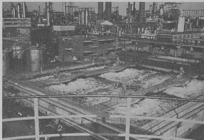
Bassins d'activation de l'installation d'eaux usées de la Shell à Cologne.
