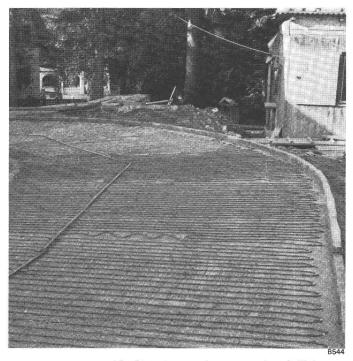
pour parer aux dégâts et aux dangers dus à l'hiver. Et cela, d'une manière propre et efficace et sans atteinte à l'environnement. Pose simple et rationnelle des boucles chauffantes prêtes à être raccordées, consommation minime, tels sont les avantages essentiels de ce système. Documentation détaillée à disposition.
