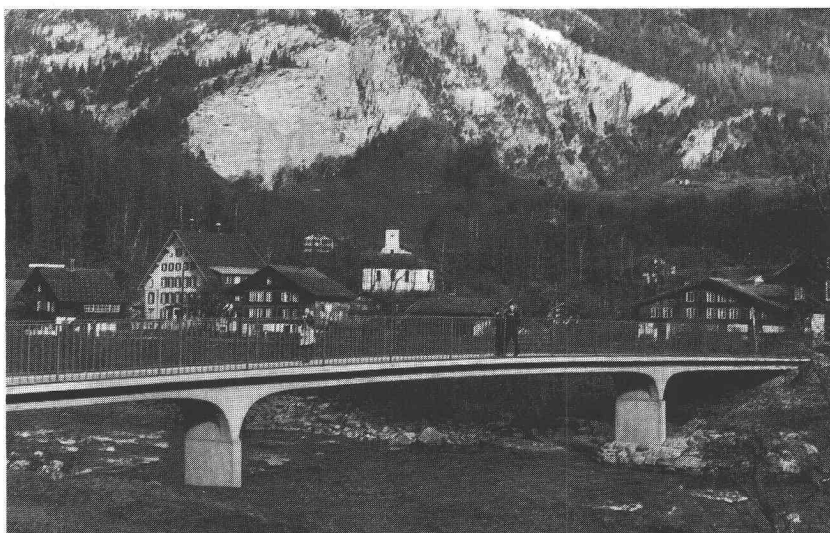
Passerelle sur l'Aar à Innertkirchen, construite en 1951.
