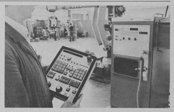
La commande Robot Control de Siemens sur un robot industriel du type 601/60 de la société Kuka au cours d'une opération de soudage par points.
