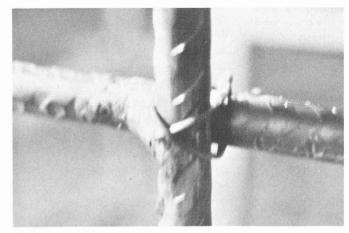
Fig. 12. — Liaison d'armatures par soudure.
