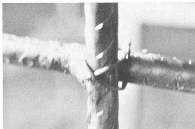
Fig. 12. — Liaison d'armatures par soudure.
