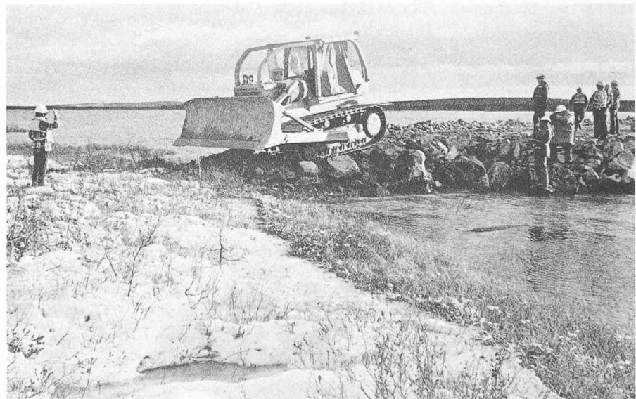
Fig. 21. — Construction du barrage de la Caniapiscau.
