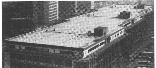
B488 Port-franc, Genève – Architecte: Koehlin René et Mozer Marc, Genève 7'000 m 2 fixés mécaniquement
