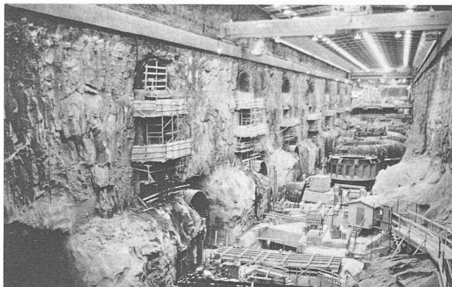
Fig. 11. — Photo de la centrale L.G.2 en construction. Les trois premiers groupes seront en activité fin 1979.
