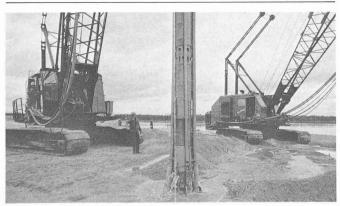
Fig. 16. — Les travaux de vibroflottage en activité. L'aiguille vibrante est au milieu.
