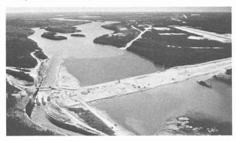
Fig. 15. — Photo durant les travaux du barrage de l'Eastmain. On distingue, à gauche, l'évacuateur des crues.
