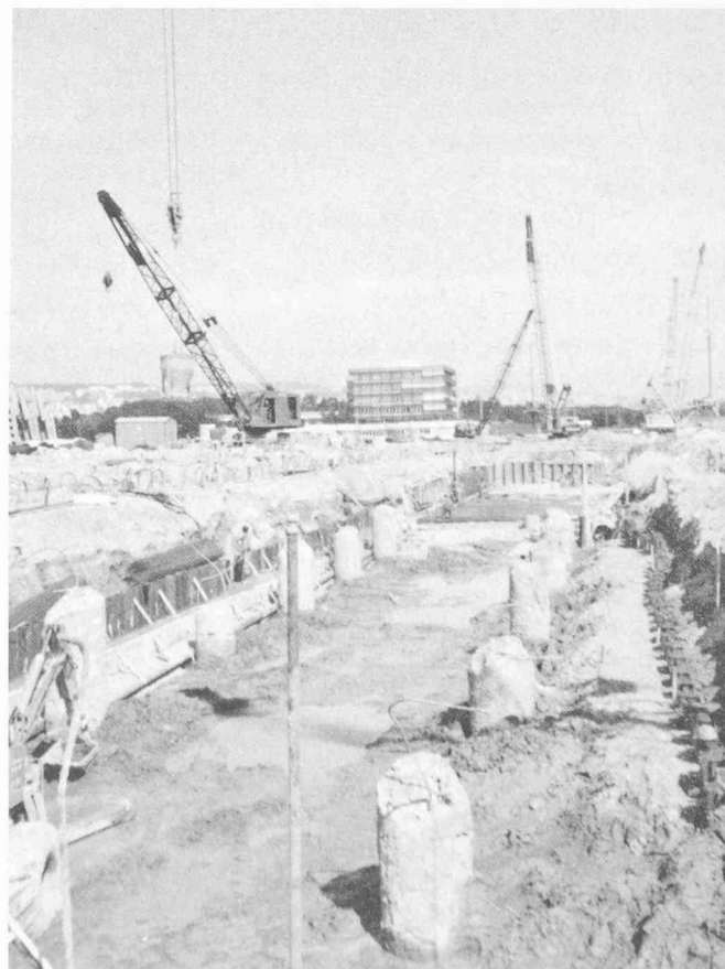
Fig. 10. — Pieux de fondation d'une galerie technique.
