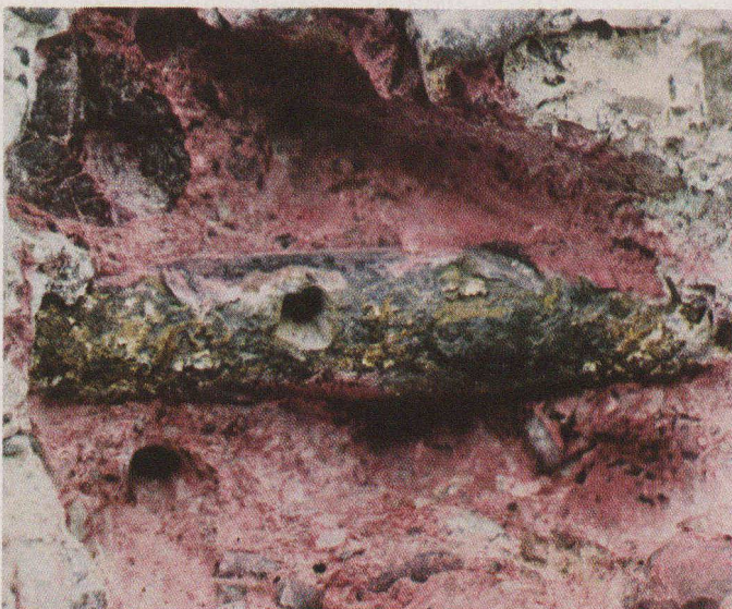
Pont C. — Le tiers inférieur de cet acier est atteint par la carbonatation et l'oxydation l'a déjà désolidarisé de sa couverture de béton.
