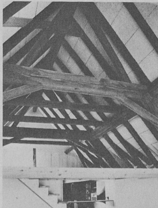
600 m 2 de Schichtex Spécial 75/III , face visible peinte à la dispersion, posée sur chevrons.
