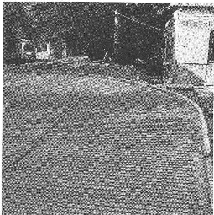
Emission de chaleur exactement à l'endroit désiré. Grâce aux câbles chauffants et aux boucles chauffantes Siemens-Prototherm. En particulier:
