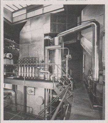
Chaudière de récupération Sulzer dans l'usine d'incinération d'ordures de Lucerne (production: 1,6 t/h de vapeur saturée à 4,8 bars).
