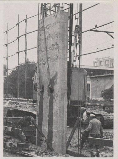
Fig. 25. — Descente d'un élément de paroi préfabriqué dans la fente pratiquée dans le sol.
