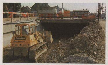
Fig. 26. — Excavation de la future halte d'Opfikon.
