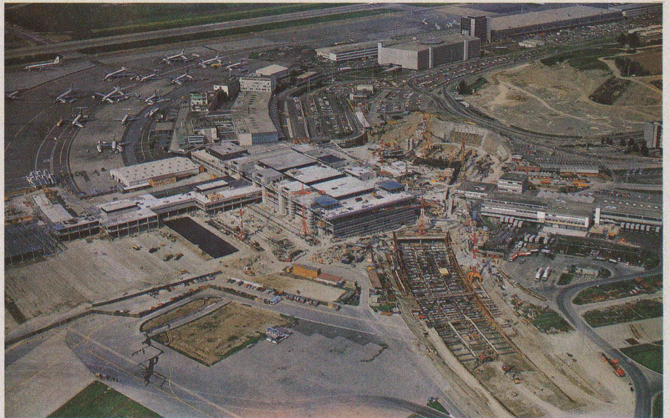
Fig. 13. — Vue générale du chantier « gare de l'aéroport ». Au milieu, l'aérogare B, située au-dessus des installations ferroviaires dans la zone du lot n° 1 (ci-contre).
