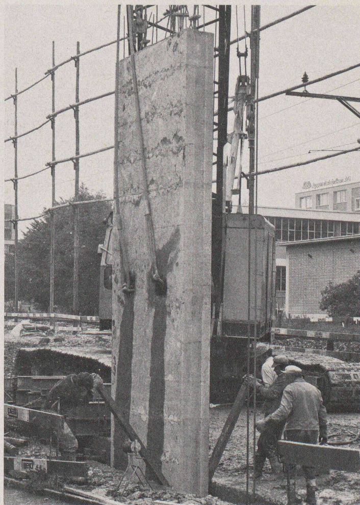
Fig. 25. — Descente d'un élément de paroi préfabriqué dans la fente pratiquée dans le sol.
