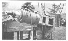
Fig. 17. — Détails de têtes d'ancrage et de vérins de 500 tonnes type BBRV.
