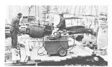
Fig. 18. — Détails de têtes d'ancrage et de vérins de 500 tonnes type VSL.
