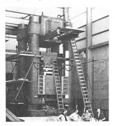
Fig. 22. — Vue d'une presse en cours de montage. Constructeur de la presse: Von Roll SA, Klus. Précontrainte: Losinger Ltd, VSL International,
