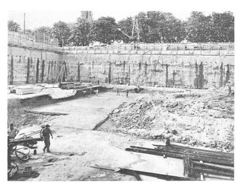
Fig. 8. — Vue du chantier. 8 000 m de tirants réinjectables démontables BBRV-IRP de 50 tonnes ont été employés pour ancrer la paroi moulée formant l'enceinte. Le sol, de mauvaise tenue, était constitué de limons argileux et de sables fins.
