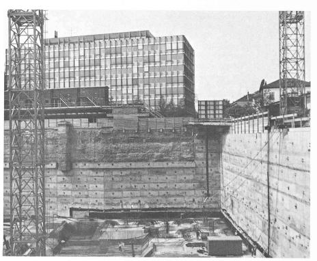
Fig. 1. — Fouille de la banque de Bâle.
