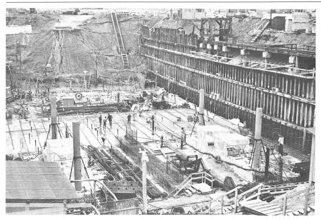
Fig. 9. — Vue du radier de fondation en voie d'exécution. Ingénieurs: Ingenieurgemeinschaft Locher & Cie AG & Aschwanden & Speck, Zurich. Entreprise: Swissboring SA, Zurich.
