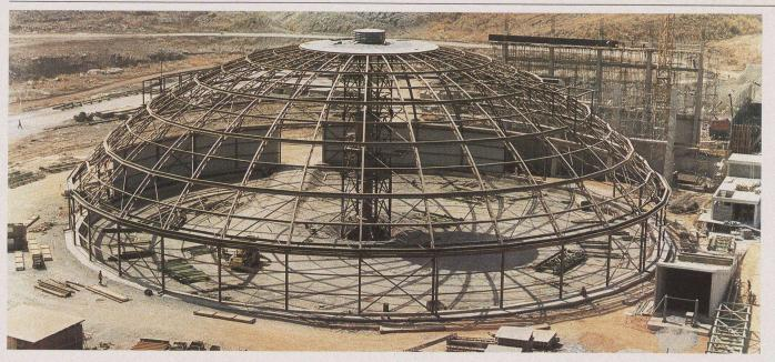
Fig. 8. — Structure de la coupole en cours de montage.
