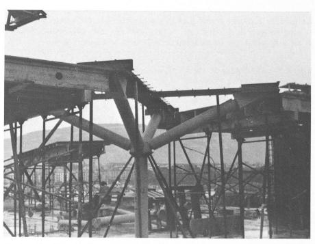
Fig. 4. — Vue d'ensemble d'une colonne en cours de montage.
