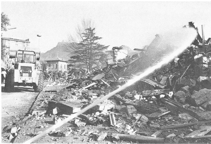
Fig. 5. — Début de chute de la façade côté rue Maraini (à gauche).
