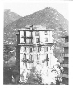
Fig. 3. — Tassement provoqué par le minage des murs intérieurs. Début de chute de la façade tournée vers le photographe. Direction générale de chute vers la colline dont le sommet est visible à l'arrière-plan.
