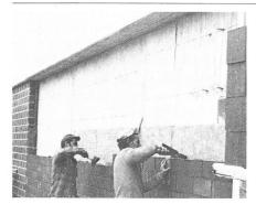
Fig. 18. — Construction de la station: Une isolation thermique de 8 cm d'épaisseur est placée entre l'ossature en béton armé et le revêtement en briques de terre cuite.
