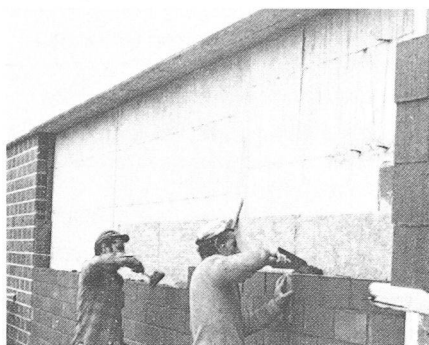
Fig. 18. — Construction de la station : Une isolation thermique de 8 cm d'épaisseur est placée entre l'ossature en béton armé et le revêtement en briques de terre cuite.
