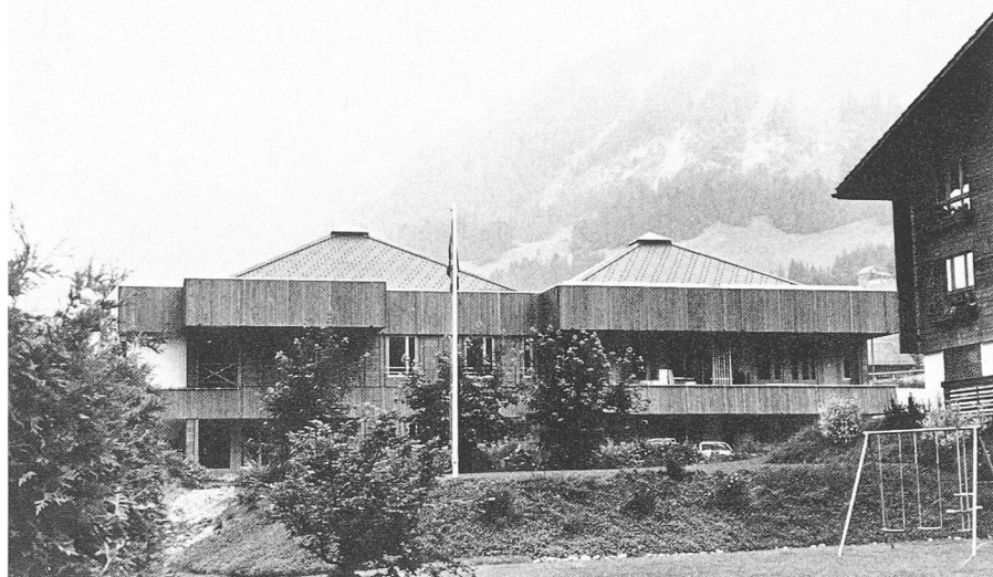
Fig. 7. — Façades et balcons (photo Jean Lugrin).
