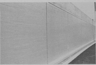
Deux couches de protection de dispersion à base de résine époxyde à deux composantes Rivalfix 7 sur une paroi latérale dans l'échangeur autoroutier du triangle du Gellert à Bâle. La différence est bien visible entre la surface inférieure enduite de dispersion, d'un brillant mat, et de la surface en béton supérieure (non enduite car elle est située trop haut pour être atteinte par les projections d'eau). (Photo Meynadier.)
