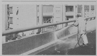
Les surfaces à protéger sont nettoyées au moyen d'un jet d'eau et de sable, les poches dues à la porosité étant simultanément ouvertes et la pellicule de ciment enlevée. (Photo Meynadier.)
