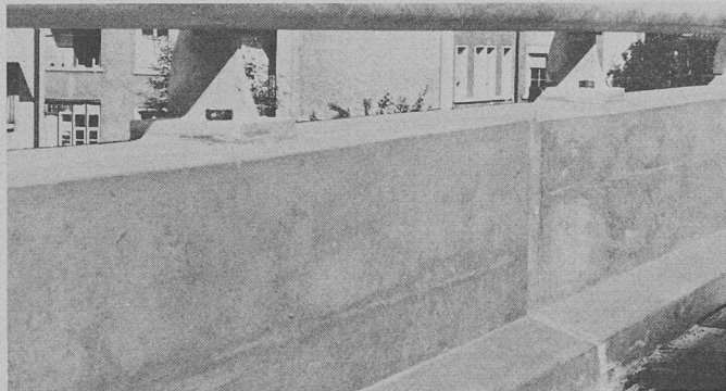
Après le nettoyage, une couche de fin mortier de ciment spécial enrichi de résine synthétique est appliquée sur la surface du parapet en béton. On obtient ainsi une surface uniforme pour l'application de dispersion à base de résine époxyde. (Photo Meynadier.)
