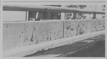
Après le nettoyage au jet d'eau et de sable, la surface nettoyée du parapet en béton sèche lentement. Les endroits sombres indiquent soit de grosses porosités, soit du béton présentant une forte capacité d'absorption. (Photo Meynadier.)
