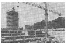
Sans fondations massives, sans liquide d'étanchéité, sans chauffage: le gazomètre sec basse pression système Gentsch
