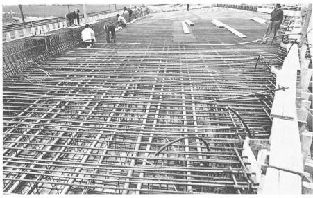
Fig. 5. — Vue de l'armature avant le bétonnage (photo Zschokke).
