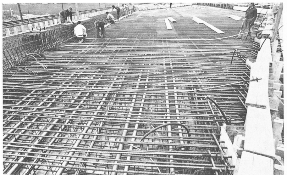
Fig. 5. — Vue de l'armature avant le bétonnage (photo Zschokke).
