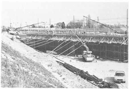
Fig. 8. — Autre vue du bétonnage. On distingue à l'arrière-plan les voies déviées.
