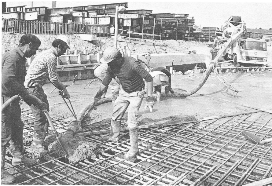
Fig. 6. — Vue partielle du tablier pendant le bétonnage (photo Zschokke).
