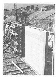
Fig. 3. — Vue d'une palée décoffrée et d'une autre en cours de montage.
