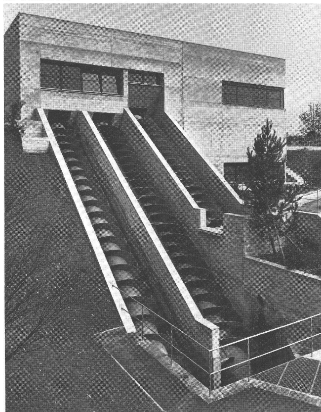
Station d'élévation pour eaux usées avec vis d'Archimède dans l'installation d'épuration de la ville d'Oltén.
