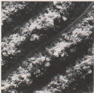
La mécanisation et la rationalisation dans la construction rend les fonds critiques toujours plus sujets à des dégâts, c'est-à-dire à des détachements de crépi. Des éléments préfabriqués en béton, des coffrages de grande surface présentent des fonds différents donnant des
