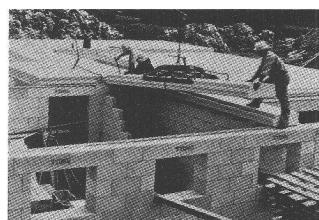
*Ytong*, une contribution à l'économie d'énergie, éprouvé depuis plus de 50 ans. Le matériau de construction idéal pour toutes les zones climatiques. *Ytong* est un béton cellulaire durci à l'autoclave, fabriqué à partir d'un matériau de base siliceux (sable), du ciment, de la chaux et d'un agent gonflant (poudre d'aluminium). Maçonnerie *Ytong* = isolation thermique élevée. Valeur K 0,37 Kcal/h m² °C.
